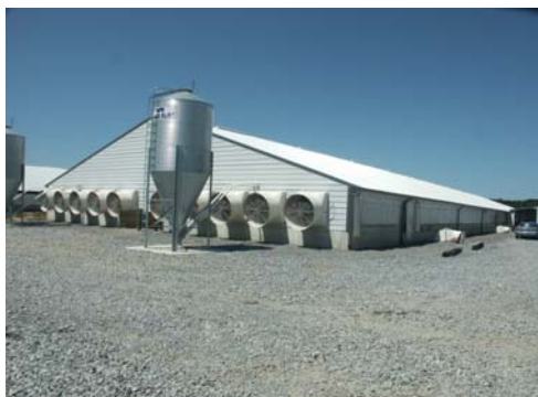
Obr.5 – tunelové větrání stáje pro prasata
