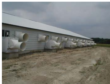
Obr.6 – kombinované větrání
