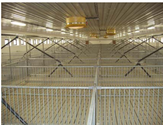
Obr.8–difúzní větrání(SPV Plevnice – BAUER 03)
